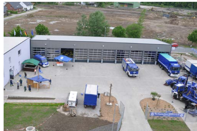
Das THW investiert in moderne Liegenschaften. Im Ortsverband Ronnenberg (Niedersachsen) wurde im Mai die erste THW-Unterkunft in Passivhausbauweise übergeben. | THW invests in modern real estate. In the local section of Ronnenberg (Lower Saxony), the first THW accommodation in passive house design was handed over in May.
