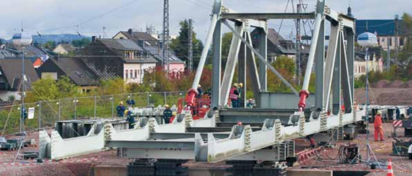
**In Konz trainierten THW-Kräfte den Bau behelfsmäßiger Eisenbahnbrücken.**
