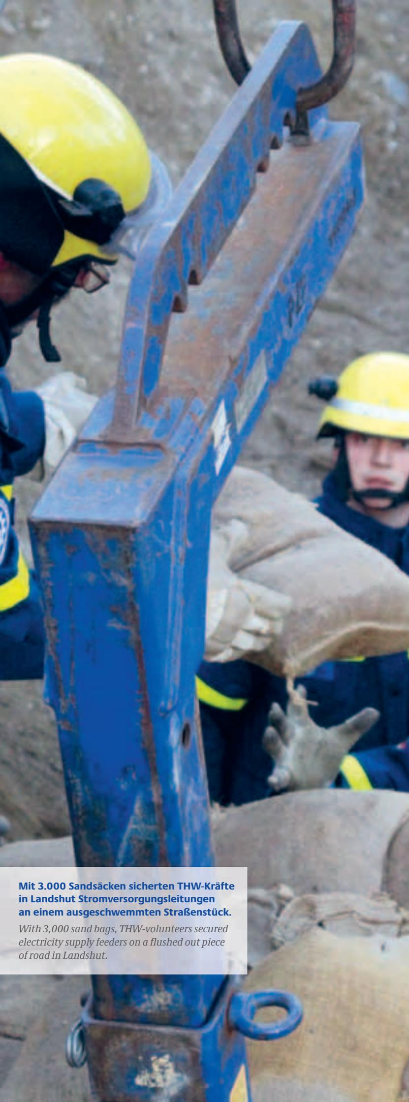
**Mit 3.000 Sandsäcken sicherten THW-Kräfte in Landshut Stromversorgungsleitungen an einem ausgeschwemmten Straßenstück.**
