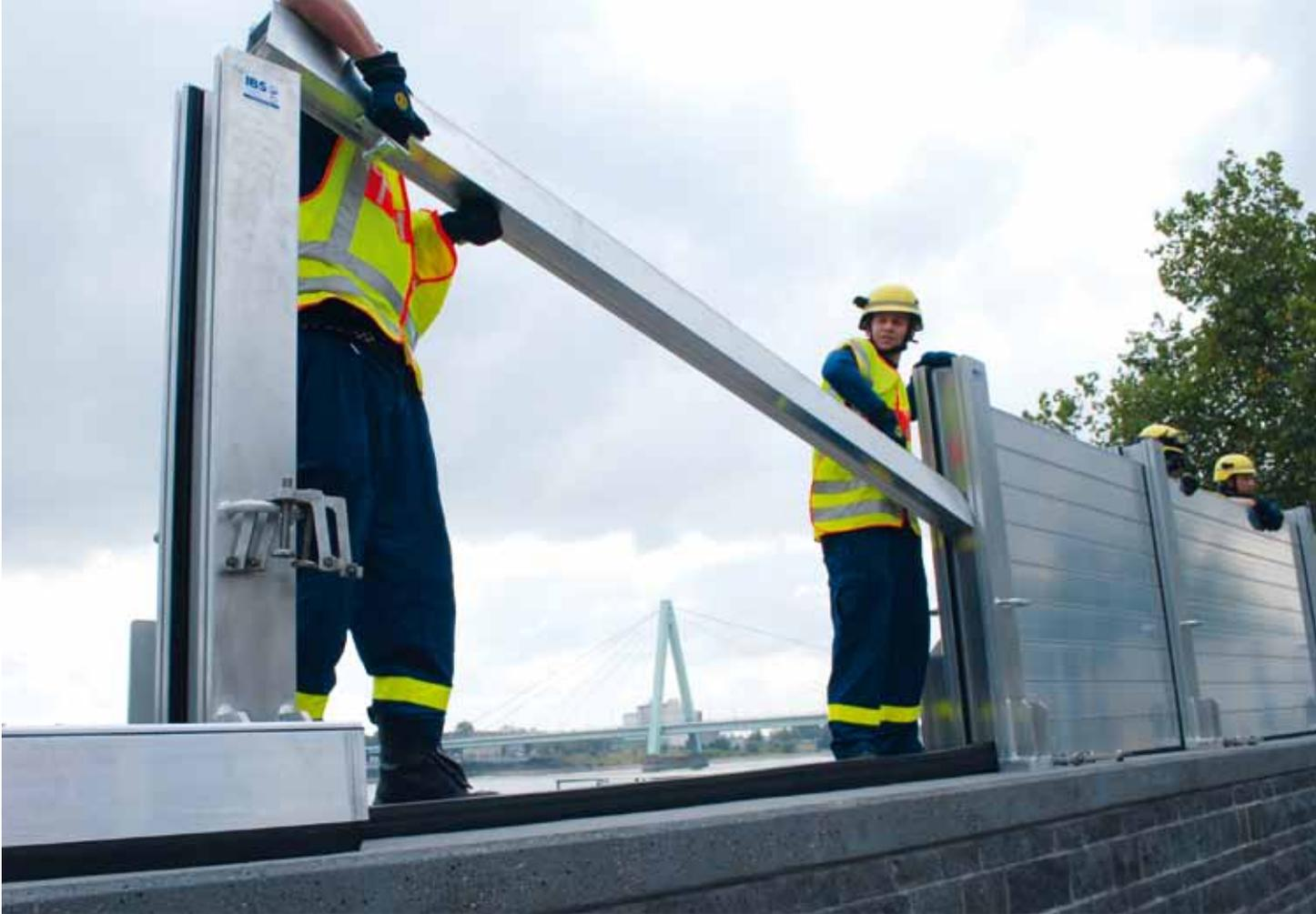
**Mit Hochwasserschutzwänden lassen sich Innenstädte schnell und effektiv schützen.**
