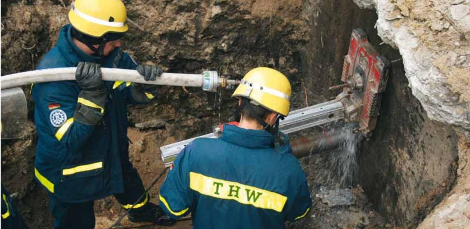
**Das Kernbohrgerät ermöglicht erste Zugänge zu Verschütteten.**
